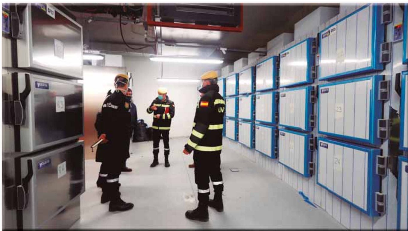
En la fotografía, instalación de cámaras en el segundo tanatorio especial ubicado en la Ciudad de la Justicia de Madrid.
